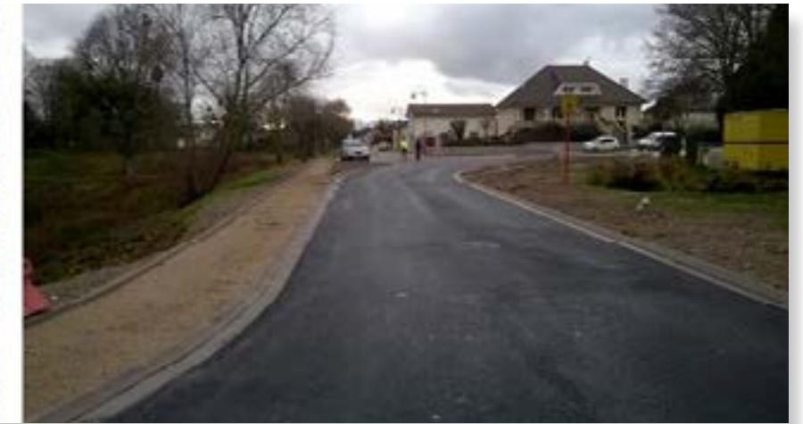
Avant/Après : rue de la Procession - Aulnay-sur-Marne
