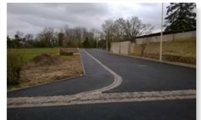
Avant/Après : Rue de la Procession - Aulnay-sur-Marne
